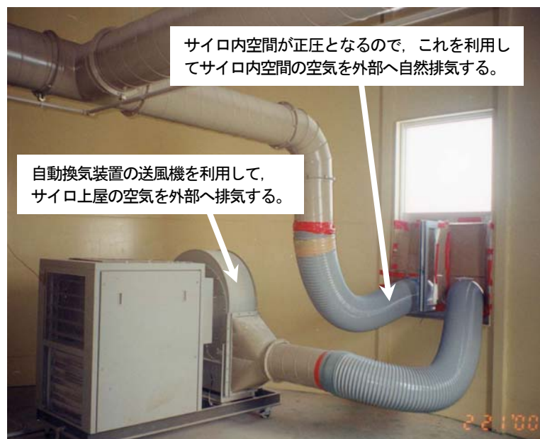
写真 8 サイロ内空間自動換気装置のダクト配管 変更後の様子（応急処置）
